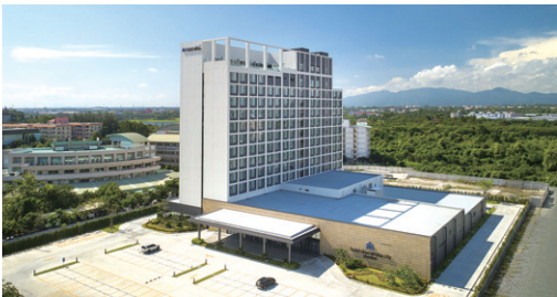
アマタシティ チョンブリ工業団地内の玄関口に立地。商業施設や医療・教育施設などが整備され、今後この一帯はアマタシティ チョンブリのゲートウェイエリアとして発展が期待されている。
