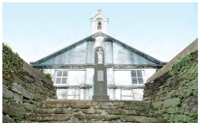
左/大野集落に住む26戸の信徒のために地元産の玄武岩を積み上げて造られた大野教会堂。レンガのアーチと西欧流の目地材で仕上げた石壁はド・ロ神父が考案。当時の姿を維持する貴重な教会堂だ。 右/ド・ロ神父と信徒が協力して建てた出津教会堂。風が強い外海地区の風土を考慮し軒が低く簡素な外観に。住民の福祉と生活向上に尽力したド・ロ神父への敬愛の証がサンセットロードに架けられたフランス国旗と同じ青・白・赤3本のトリコロールの橋だ。
